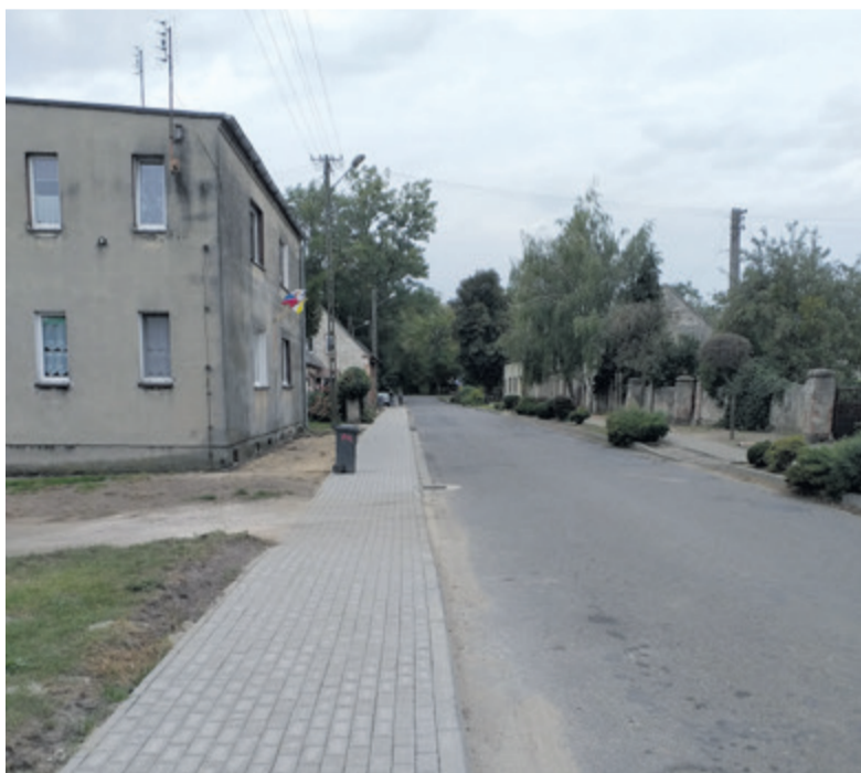
● Wyremontowany chodnik w Posadowie
