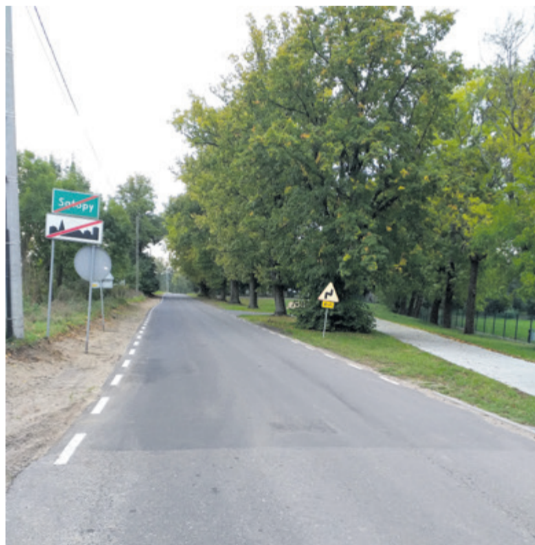
● Remont nawierzchni w Sątopach
