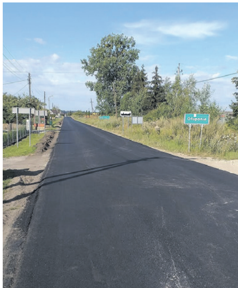
● Nowa nawierzchnia w Głuponiach
