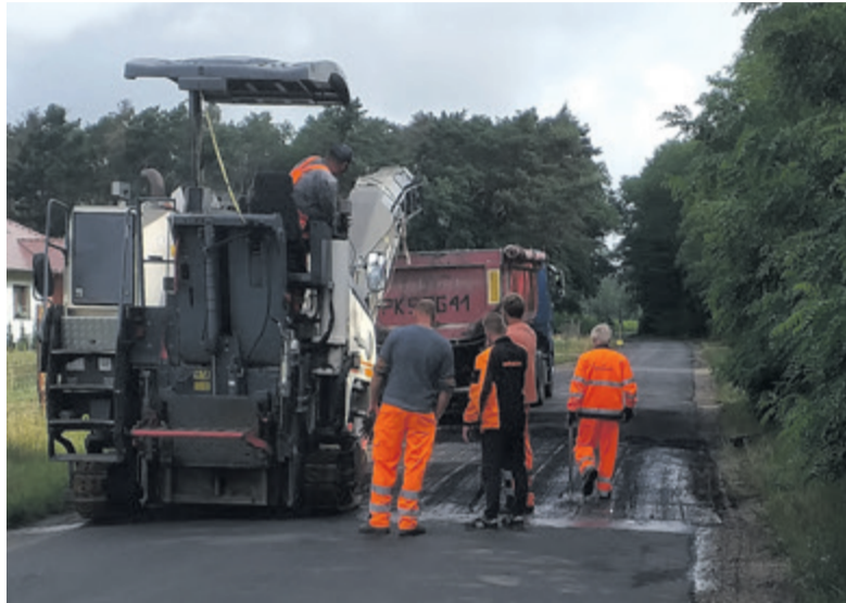
● Prace remontowe w Nowej Wsi Zbąskiej
