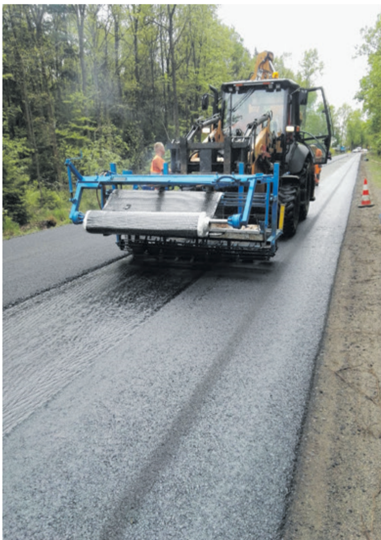
● Prace na drodze Przyprostynia - Chobienice
