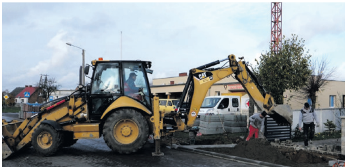
● Budowa chodnika w Łagwach
