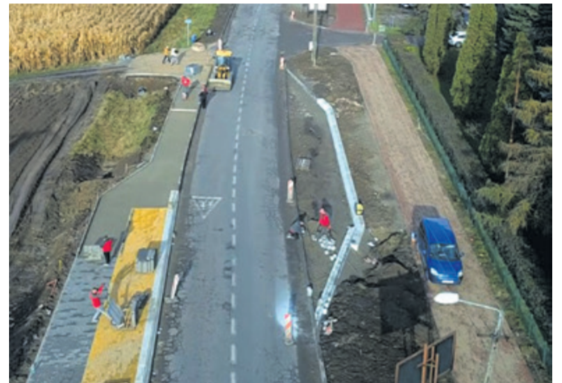
● Przebudowa drogi powiatowej Opalenica - Lwówek - widok z lotu ptaka
